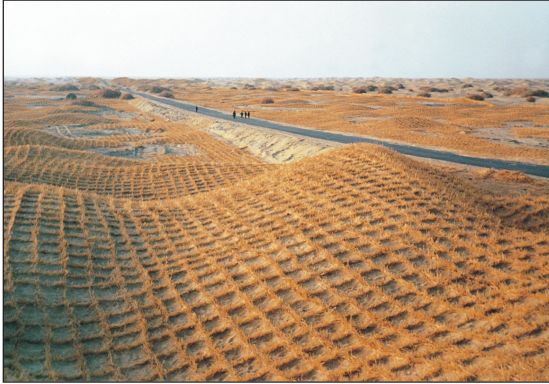
图 2 草方格固沙防护工程案例
